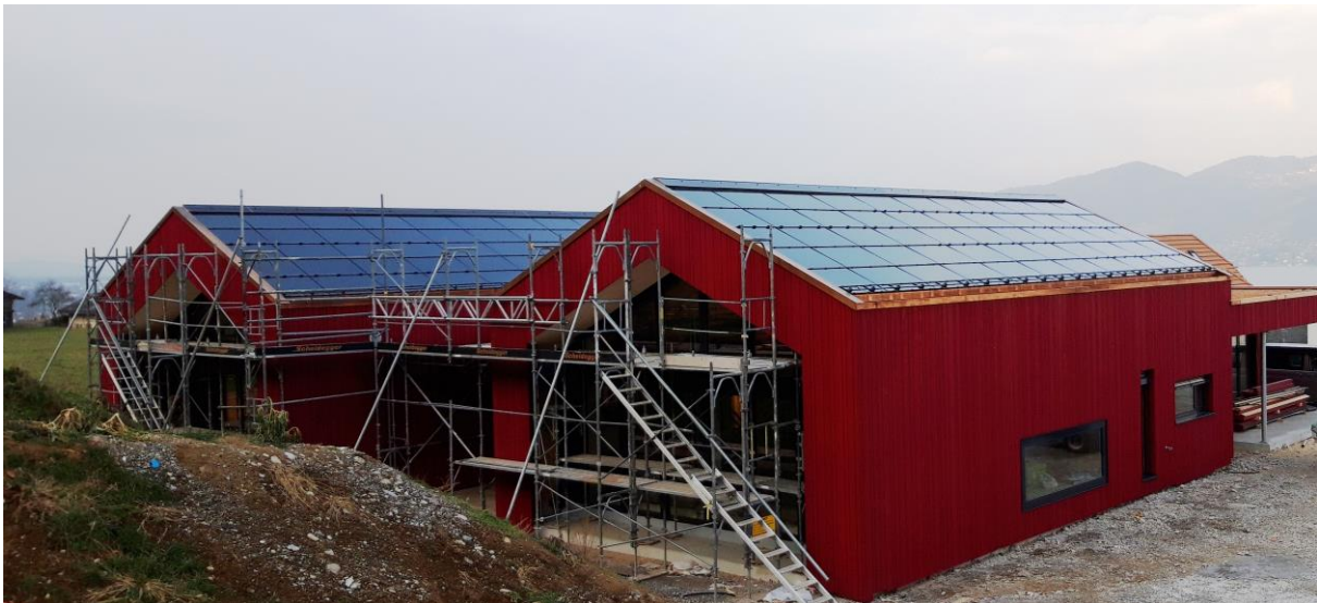
Neubau Doppelkindergarten Roggern, Einigen, Dezember 2018
